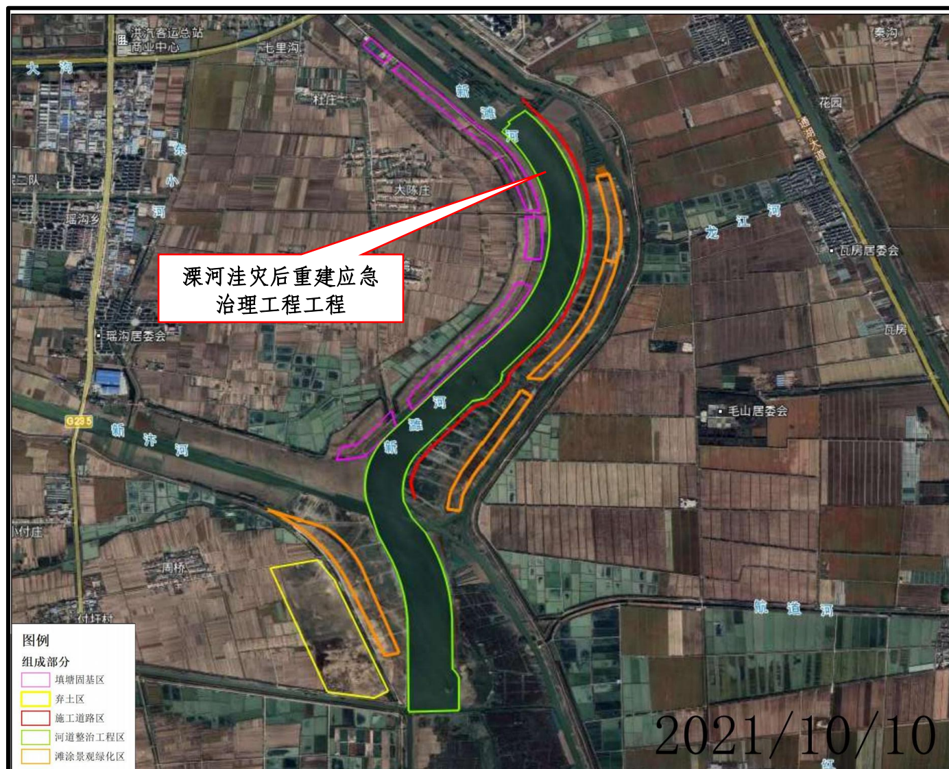
施工后影像图
