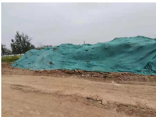
弃土区苫盖措施
