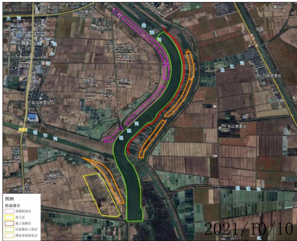
图 2-3 完工后影像图（2021 年 10 月）
