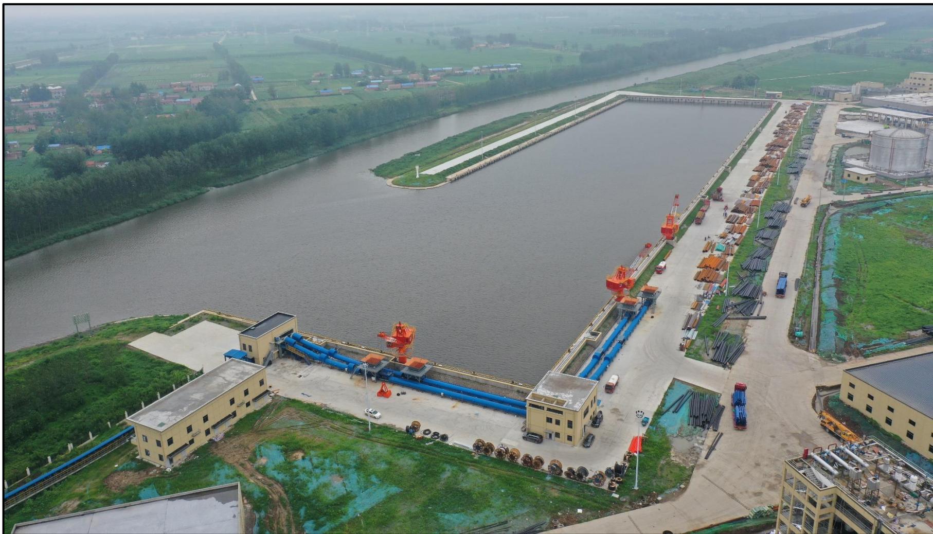
施工后影像图
